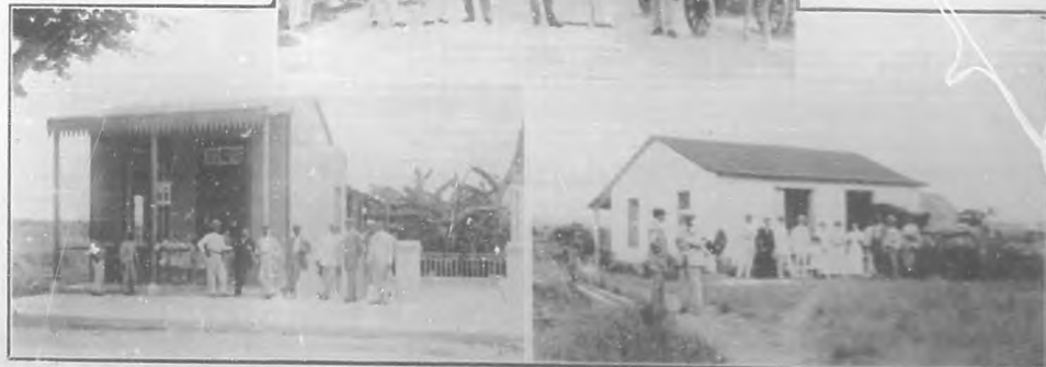
EL REGALO DE "BOHEMIA".—Vista que representa: Carretera que conduce á los terrenos donde está el solar de Boemia que pasó en suerte á la Sra. de Marín y dos casas construidas en el mismo reparto.
